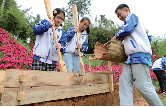
学生在基地体验筑墙。
